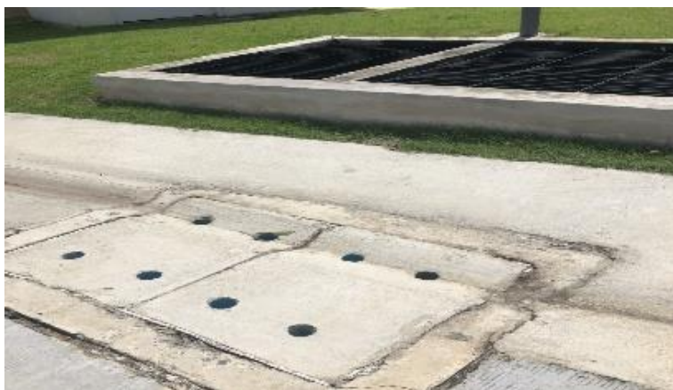
ภาพที่ 3-4 ลักษณะงานบ่อพักระบายน้ำ
