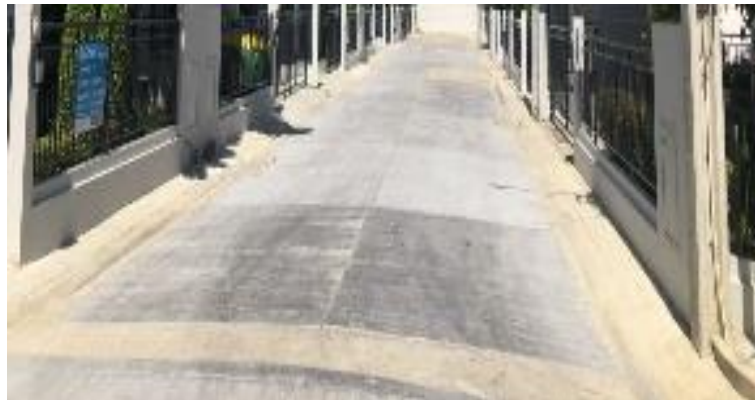
ภาพที่ 3-1 ลักษณะงานถนนคอนกรีตเสริมเหล็ก
