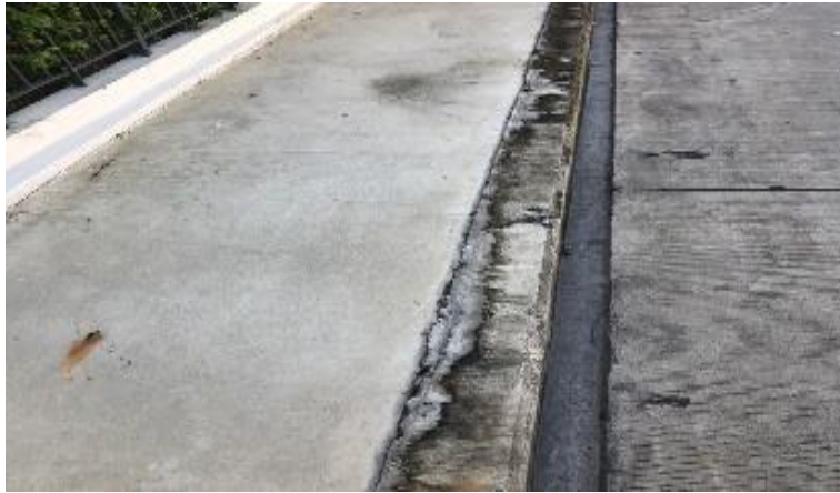
ภาพที่ 3-2 ลักษณะงานทางเท้ายกระดับ
